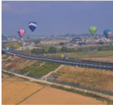
会津縦貫北道路の様子
