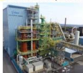
12m 3 小規模試験高炉(水素還元)
